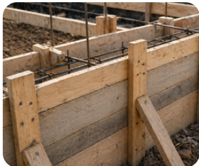
Sisteme de cofrare
