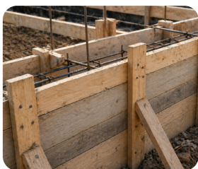
Sisteme de cofrare
