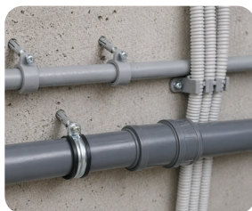
Instalații electrice și sanitare
