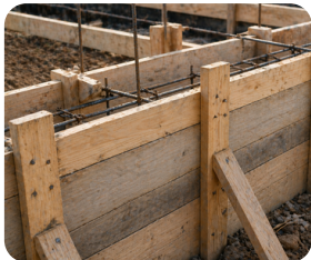
Sisteme de cofrare
