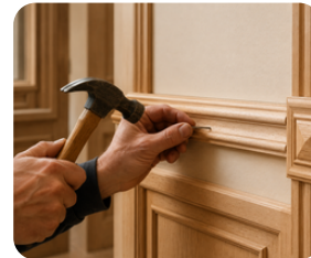
Fixarea baghetelor și ornamentelor
