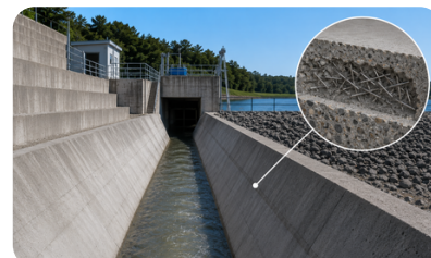
Construcții hidrotehnice și canale colectoare
