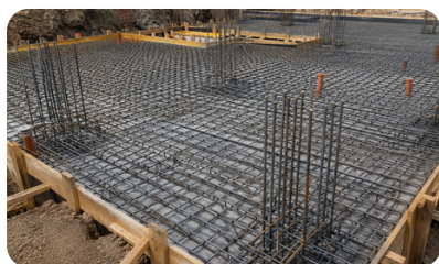
Armarea fundațiilor și radierelor
