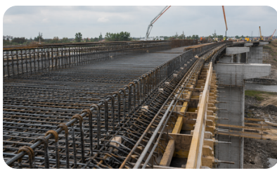
Poduri, pasaje și lucrări de infrastructură
