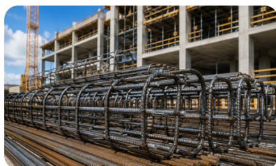
Legarea armăturii din fier-beton
